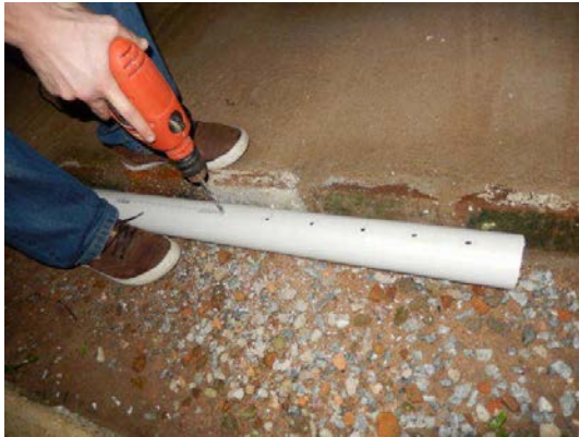
Figura 3: Confeção dos sistemas de drenagem.
