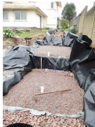
Figura 12: Módulo I e II com camada final de pedregulho médio.
