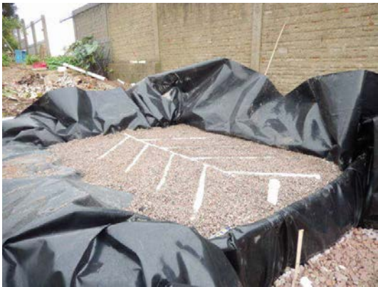
Figura 9: Camada final de pedregulho médio recobrindo sistema de alimentação módulo I – WCV.
