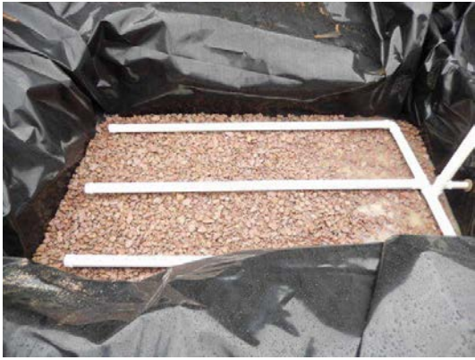
Figura 7: Camada de drenagem do módulo I – WCV e sistema de drenagem.
