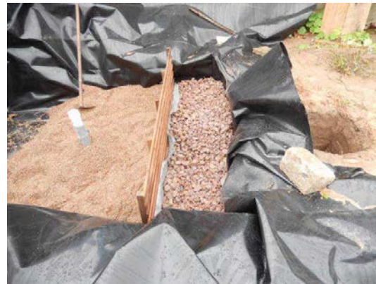
Figura 10: Composição das camadas do módulo II – WCH.
