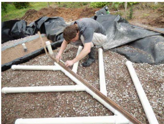
Figura 5: Instalação de forma nivelada do sistema de alimentação do módulo I – WCV.
